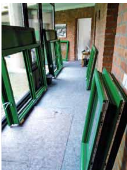
Die Fenstersanierung hat das Schwesternhaus in Bergisch Gladbach einige Wochen beschäftigt
